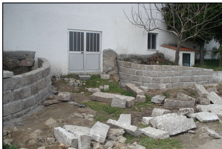
Obras na parte de trás do clube, junto à entrada para a cozinha.
